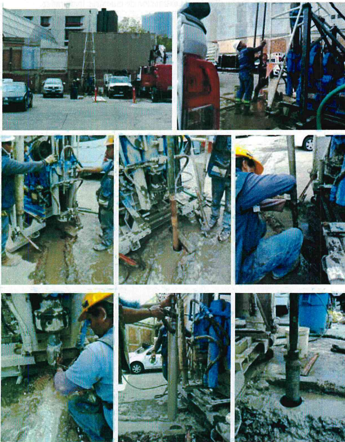
Figura 17. Trabajos realizados durante la ejecución de los sondeos
