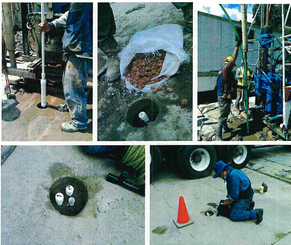
Figura 21. Instalación del tubo de observación y piezómetros
